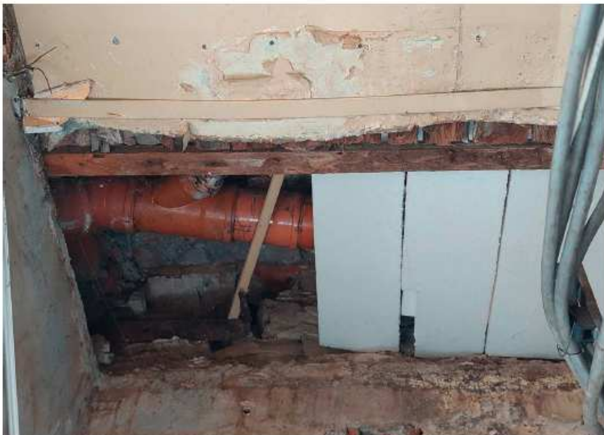
Poškozený strop pod bytem 1 (technologie 109):
